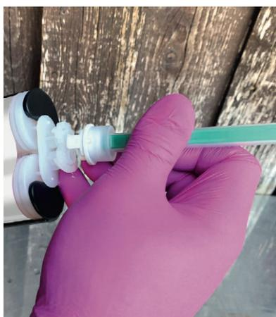
Placez la buse mélangeuse sur la cartouche. Pour éviter toute contamination croisée, la buse de mélange ne peut être placée que dans une seule position, de sorte que même les cartouches ouvertes puissent continuer à être utilisées. Le manchon d'étanchéité est maintenant réglé avec un quart de tour sur la buse de mélange et fixé. Le produit est maintenant prêt pour le traitement.
